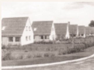
Fra begyndelsen af 1950'erne kom der fart i byggeriet af boliger. Inden for parcelhussektoren var det i begyndelsen kæde- og rækkehuse der prægede udviklingen, men efterhånden skiftede billedet til tritiliggende parcelhuse.
