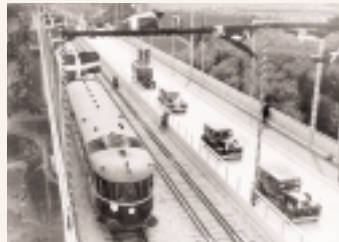
Arbejdet med opførelsen af Lillebæltsbroen startede i 1929 og den 825 m lange vej- og jernbanebro til en pris af 25 mio.kr. stod færdig den 14. maj 1935.
