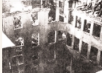
Under stormen på Amalienborg den 19. september 1944 sættes Kjøbenhavnske Re's senere hovedkontor i Amaliegade 39 i brand; ejendommen genopføres i ny skikkelse efter krigen. Kjøbenhavnske Re flytter ind i den nye bygning i 1949.
